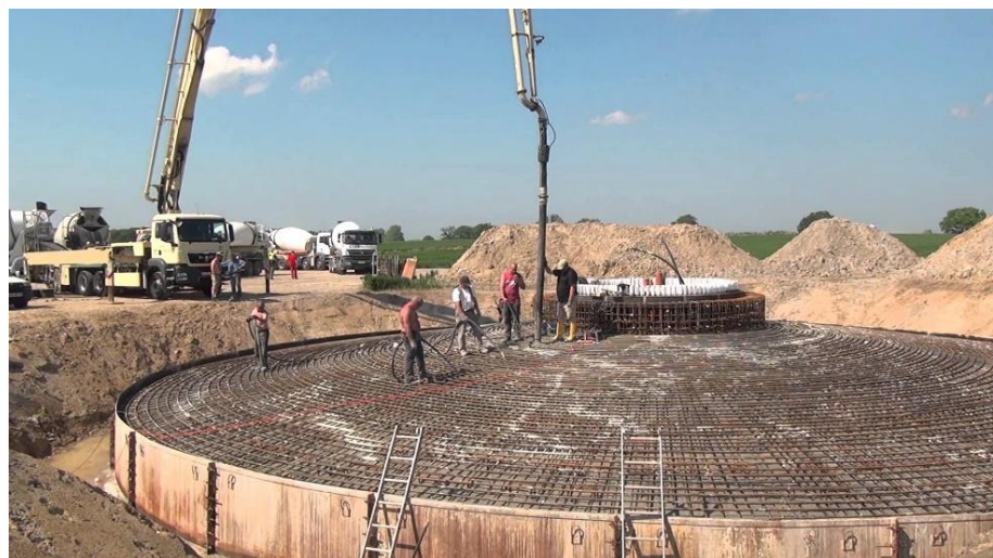
Erdsonden verboten, Windkraftanlagen erlaubt? Fundament für eine Windkraftanlage
